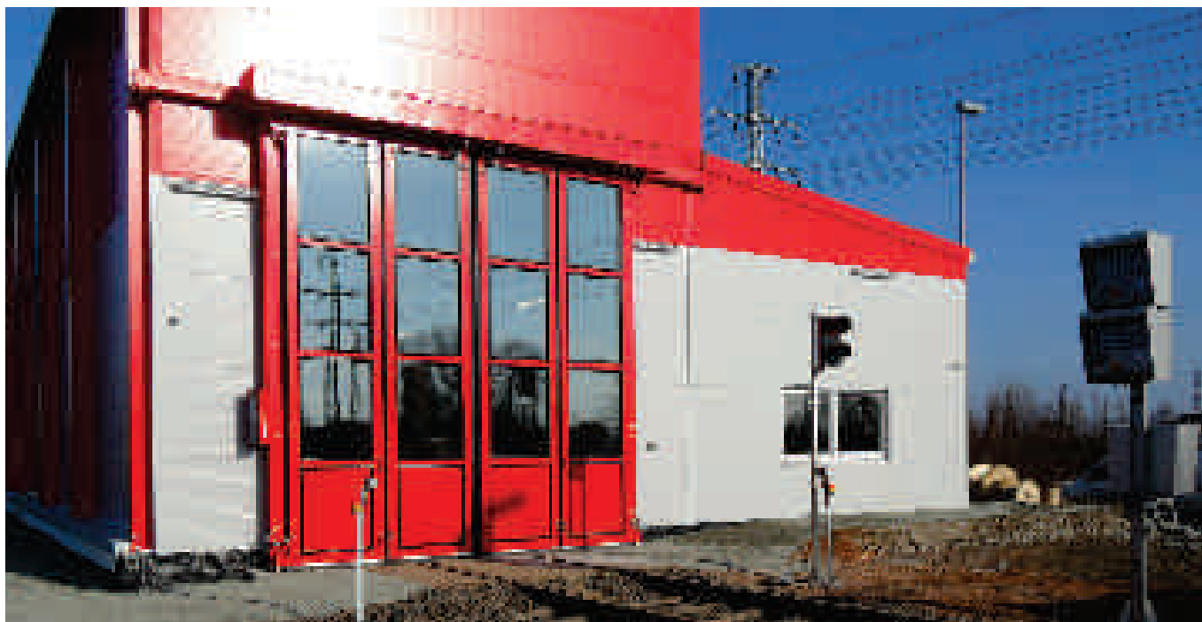
Budowa nowoczesnej myjni taboru może być prosta i szybka przy wykorzystaniu gotowych prefabrykatów Foto: B+F Beton- und Fertigteilgesellschaft mbH Lauchhammer
