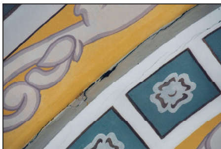
Rys. 6. Zarysowany styk powłoki sklepienia z żebrzem
