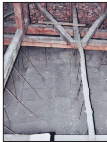
Rys. 13. Widok kolebkowego sklepienia „Rabitz” nad nawą
