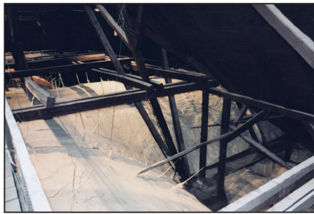
Rys. 8. Ocieplone sklepienia nad nawą główną i transeptem Fig. 8. Thermal isolated vault above the crossing Rys. 9. Ocieplone sklepienia nad nawą główną i nawą boczną Fig. 9. Thermal isolated vault above the nave and aisle
