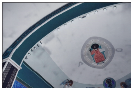
Rys. 15. Nowe otwory wentylacyjne w sklepieniu nad prezbiterium
