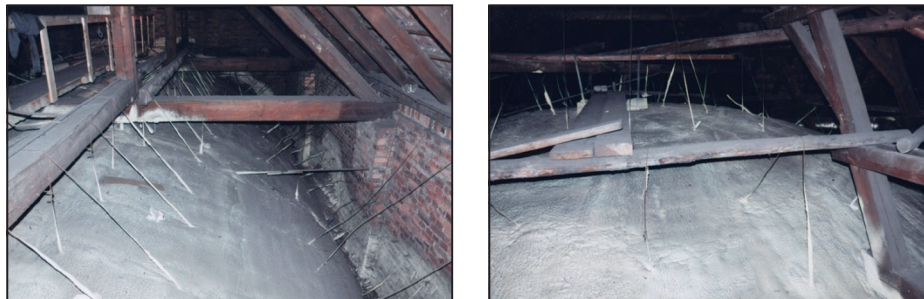
Rys. 17. Ocieplone sklepienie kolebkowe nad nawą kościoła Fig. 17. Thermal isolated of „Rabitz” barrel vault above the nave Rys. 18. Ocieplone sklepienie żagłowe nad przecięciem nawy z transeptem Fig. 18. Thermal isolated of „Rabitz” dome above the crossing
