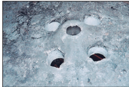
Rys. 4. Podwieszenie konstrukcji sklepienia elementów do więzby dachowej (w dali widoczne żebro w powłoce) Fig. 4. The hanger construction of the vaults to the roof truss construction (visible in the distance the rib of the shell of the vault)
