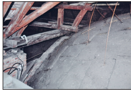
Rys. 14. Widok żagłowego sklepienia „Rabitz” na przecięciu nawy z transeptem
