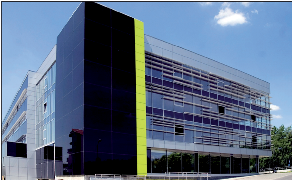
Rys. 1. Fotografia PNT „Silesia” z zainstalowanymi panelami PV (elewacja północno-zachodnia) Foto. 1. PNT „Silesia” photograph with installed PV panels (north-west elevation)
